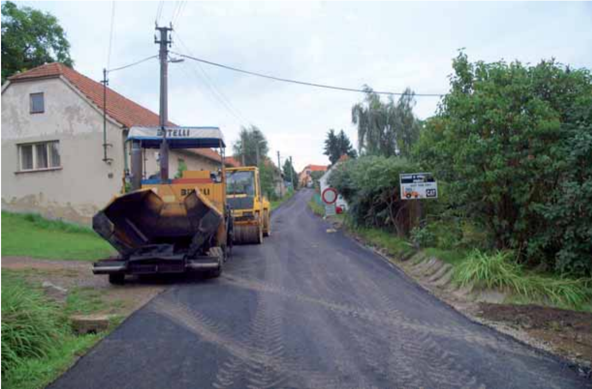
Výstavba inženýrských sítí a rekonstrukce komunikace Hlavní v Dolních Jirčanech.
