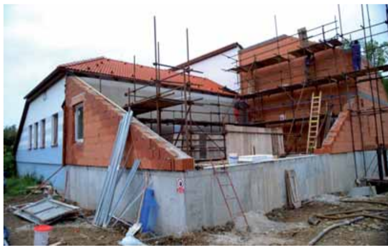
Kapacita čistírny odpadních vod po rekonstrukci stoupne na 6 000 obyvatel.
